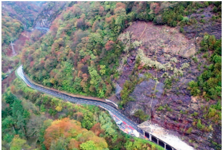
La route des Gorges de Luz exposée à de fréquents éboulements de terrain et chutes de blocs.
